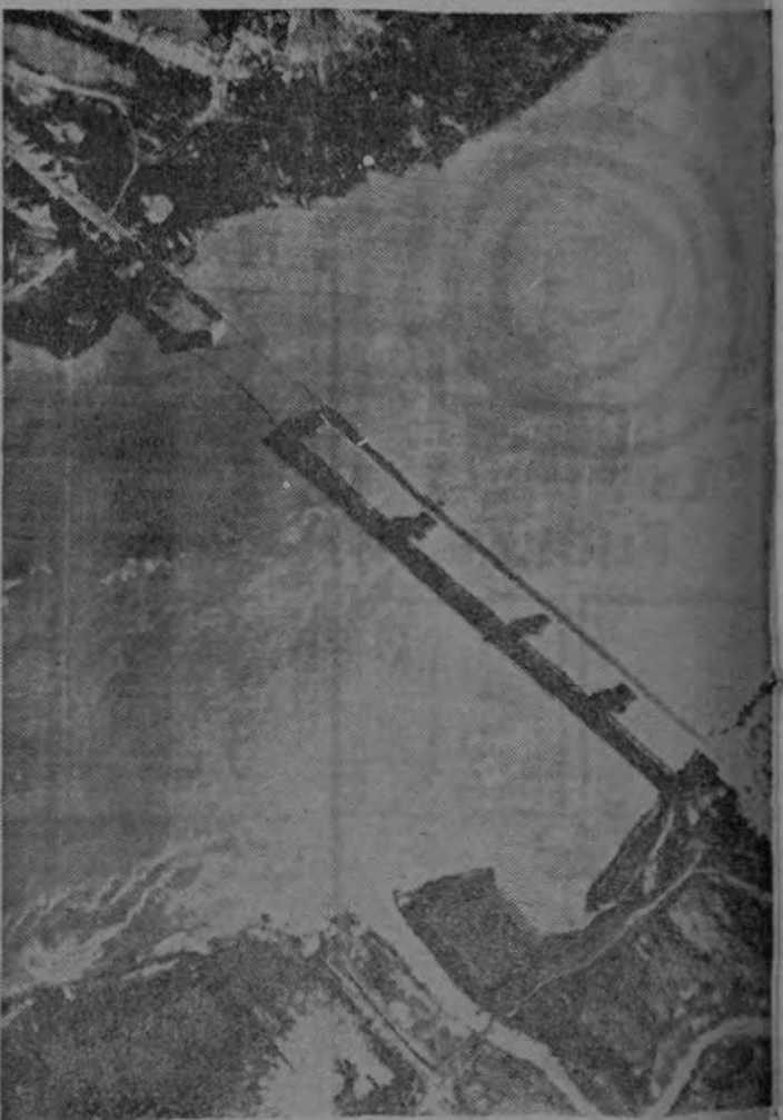
DAÑADO POR BOMBAS TELEDIRIGIDAS. — La gráfica muestra los daños causados en un puente de ferrocarril, situado a unos 40 kilómetros de Hanoi, en Vietnam del Norte cuando el 1º de junio fue bombardeado por aviones norteamericanos con bombas teledirigidas. (AP).
